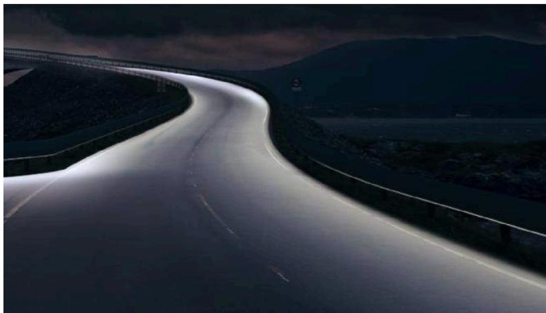
Un esempio di strada illuminata con guardrail a led, un sistema smart che elimina i pericolosi pali di sostegno delle lampade
