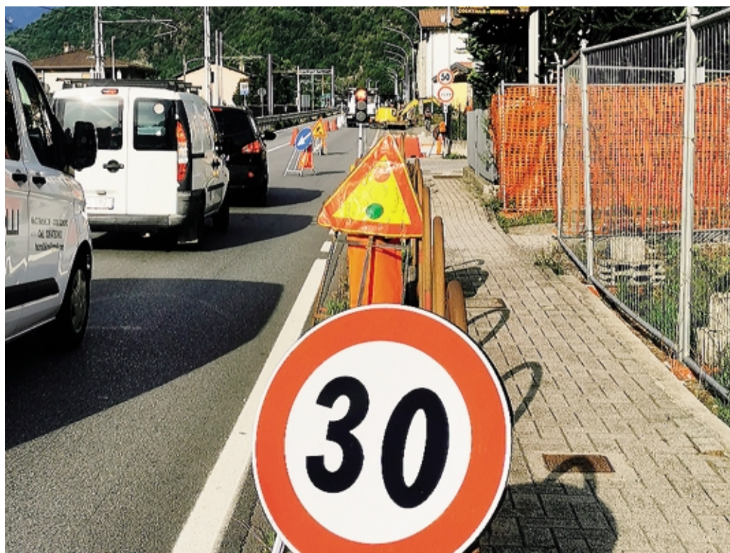
Ai grossi problemi sulla statale 36 si aggiungono quelli del cantiere di Ardenno
